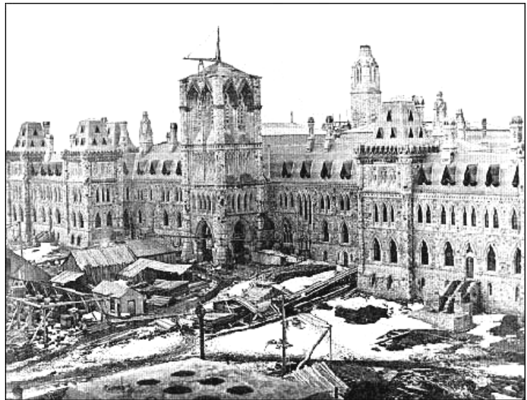
Construction du Parlement – 1865, Ottawa
