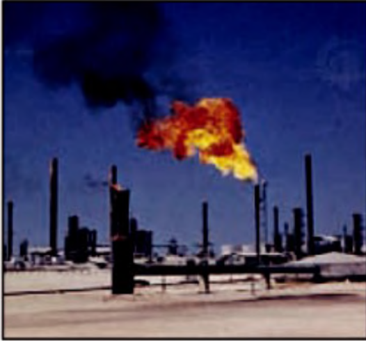
صورة (٣١) مصنع ذو مداخن ملوثة للبيئة
