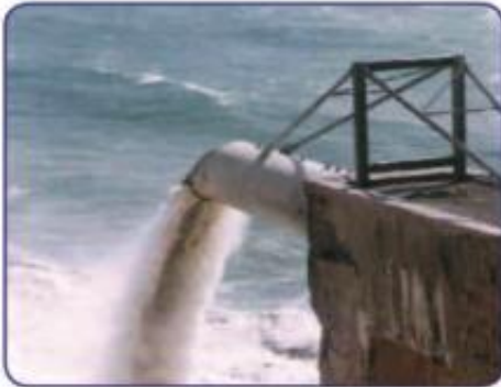
صورة (٤٢) الصرف المباشر على البحر
