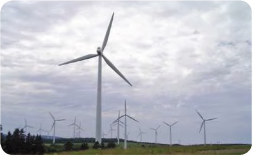
محطة توليد الكهرباء من الرياح بمنطقة الزعفرانة
