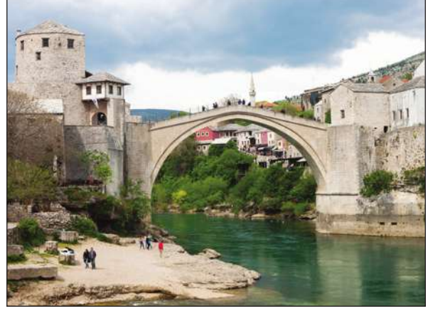
▲ Mostar Köprüs - Bosna
