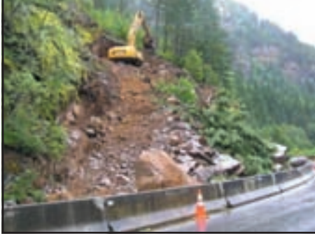
صورة رقم (٧٣) مدرجات تحد من الانهيار
