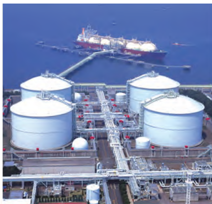
16-rasm. Suyultirilgan tabiiy gazni saqlovchi rezervuarlar.
