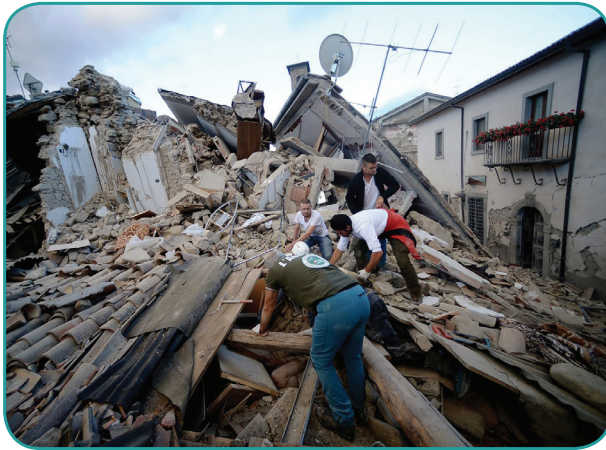
أثر زلزال في جنوب شرق آسيا
