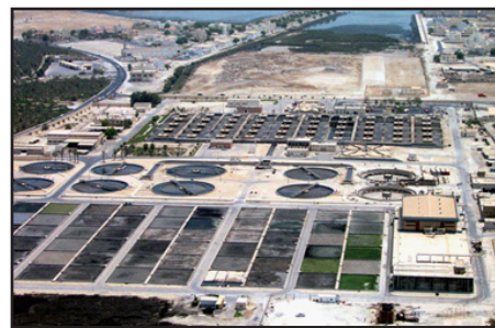
■ محطة توبلي لمعالجة مياه الصرف الصحي
