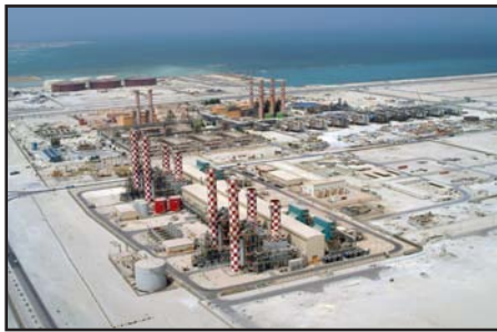
■ محطة الحد للكهرباء والماء
