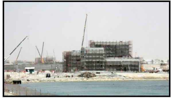
■ محطة الدور للكهرباء والماء قيد الإنشاء
