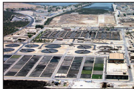
■ محطة توبلي لمعالجة مياه الصرف الصحي
