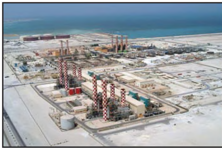
■ محطة الحد للكهرباء والماء
