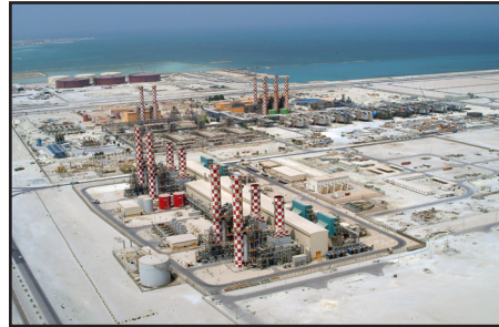
■ محطة الحد للكهرباء والماء
