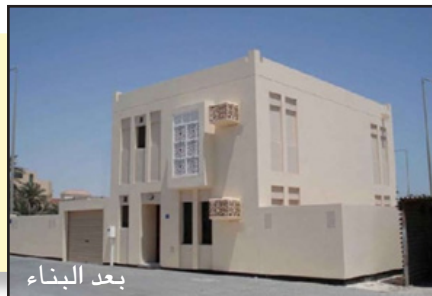
منزل بُني ضمن مشروع ترميم وإعادة بناء البيوت الآيلة للسقوط
