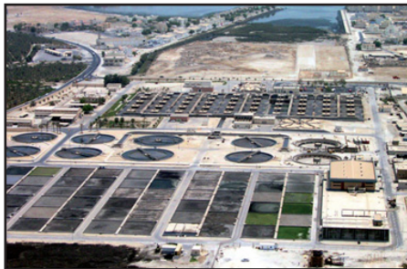
■ محطة توبلي لمعالجة مياه الصرف الصحي
