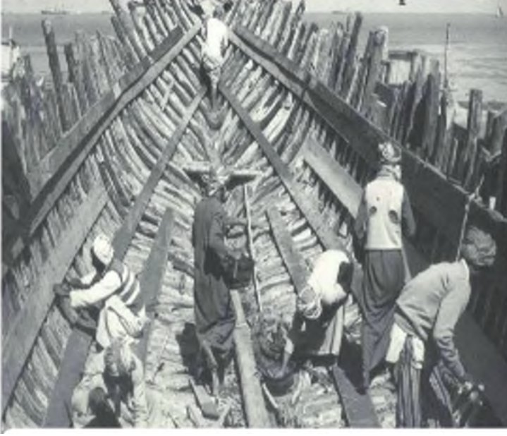
الصورة (1) صناعة نجارة السفن الشراعية (الغلافة) في الكويت
