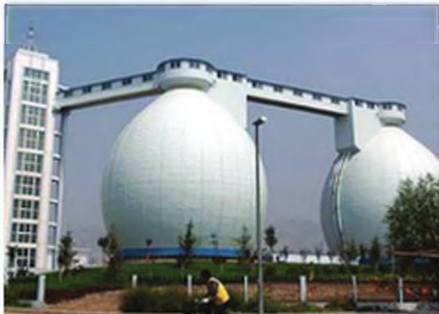
تصويرة (٩) محطة لمعالجة مياه الصرف لصحى
