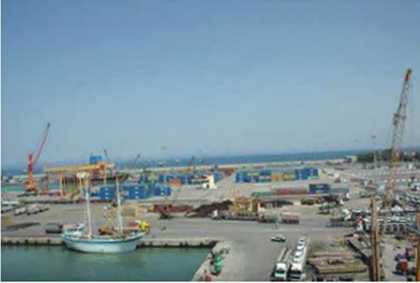
الصورة (١٦) مياه الأذقية
