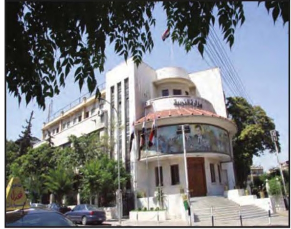
الصورة (١٠) مبنى وزارة التربية
