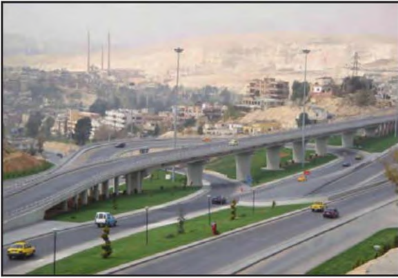
الصورة (٦) شبكة طرق حديثة
