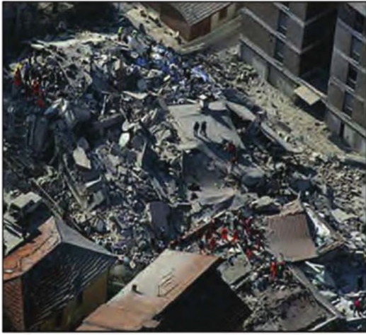
الصورة (٢) آثار زلزال مدمر
