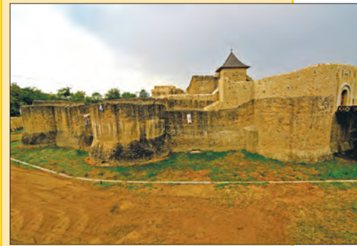
Cetatea Sucevei, după restaurare. Vedere către poartă și șanțul de apărare
