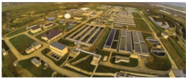
▲ Stația de epurare a apei – Cluj-Napoca
