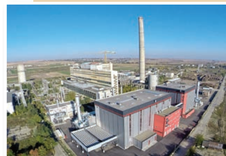
▲ Centrala pe bază de biomasă de la Suceava
