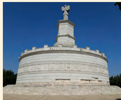
Monumentul de la Adamclisi (restaurare)
