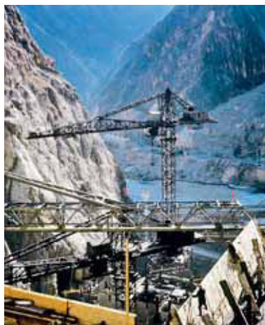
Строительство Токтогульской ГЭС
