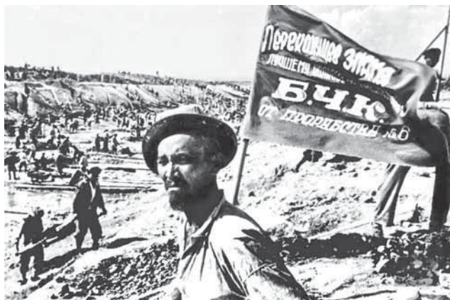
Строительство Большого Чуйского канала.
