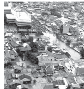
Gambar 3.11 Kerusakan lingkungan kota akibat banjir. Sumber: www.detik.com
