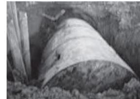
Gambar 3.10 Kerusakan lingkungan tanah Sumber: www.wikipedia.org
