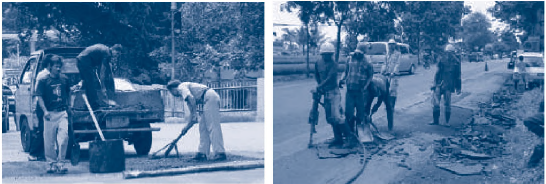
Gambar 2.9 Upaya perbaikan jalan.( www.pikiranrakyat.com ; www.wordpress.com )
