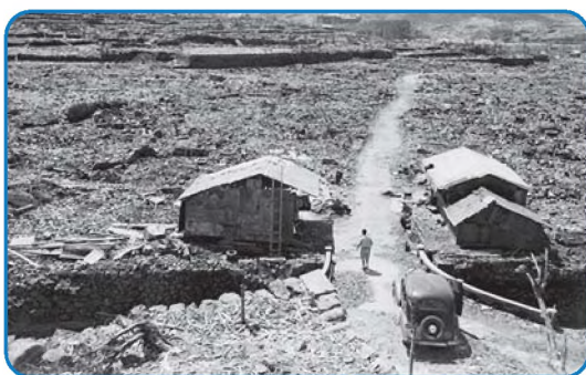
Gambar 7.3 Kerusakan akibat bom atom yang dijatuhkan di kota Nagasaki
