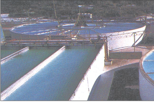
شكل (٤) معالجة مياه الصرف الصحي
