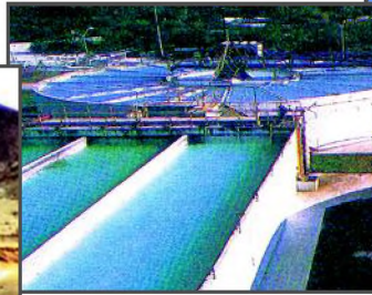
شكل (٢) محطة معالجة مياه صرف صحي
