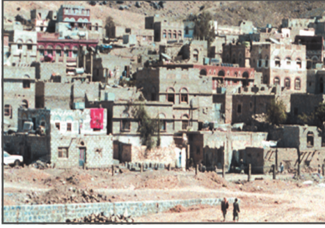
شكل (١) حي سكني مبني بطريقة عشوائية
