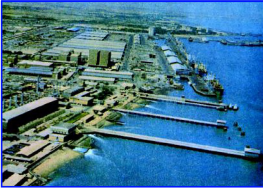
شكل (٦٥) محطة تحلية مياه البحر
