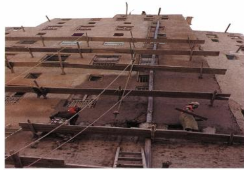
أشخاص يعملون في ترميم المباني الطينية
