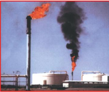
شكل ( ٨٩ ) مداخن آبار النفط
