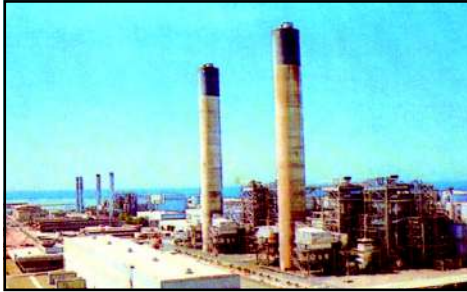
شكل (٤) محطة تحلية المياه
