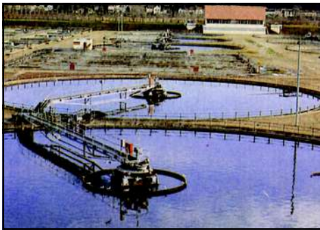
شكل (٥) محطة معالجة مياه الصرف الصحي
