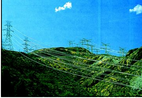
شكل (٩) خطوط نقل القدرة الكهربائية.
