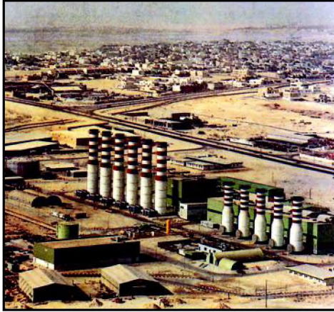
شكل ( ٤ ) محطة لتوليد الكهرباء.
