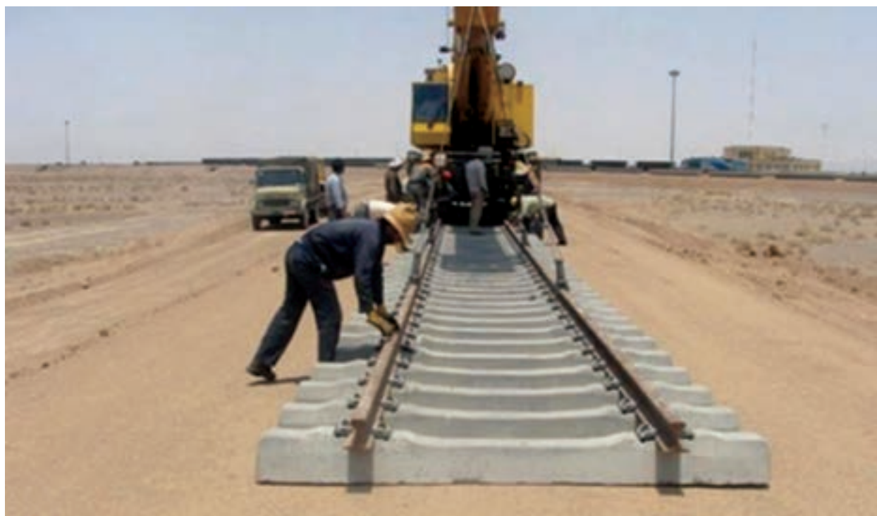
شکل ۱۵-۶- مراحل ساخت راه آهن قزوین - رشت - آستارا
