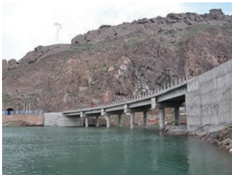
شکل ۱۶-۶- راه آهن قزوین - رشت - آستارا در حال احداث
