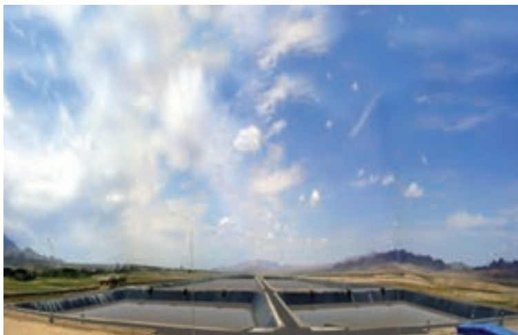
شکل ۱۶-۵- تصفیه‌خانه فاضلاب شهر بیرجند
