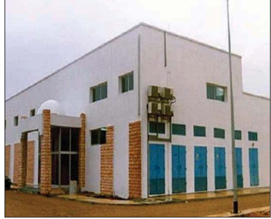
محطة تحلية المياه بجربة (منظر خارجي)
