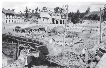
Terremoto de Ambato, 1949
