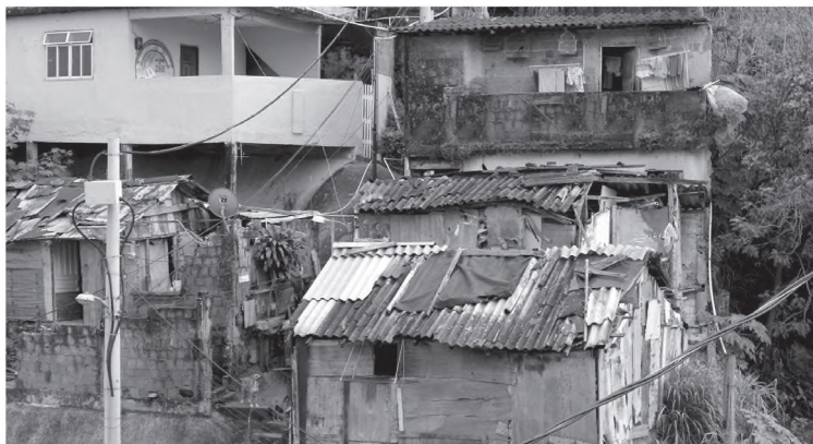
El deterioro o la baja calidad de construcción de las viviendas es una muestra del empobrecimiento de amplios sectores sociales en el Ecuador y América Latina
