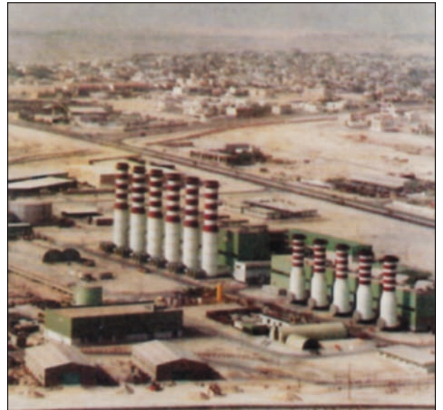
(٤) محطة الرفاع لتوليد الكهرباء وهي إحدى منجزات القطاع العام
