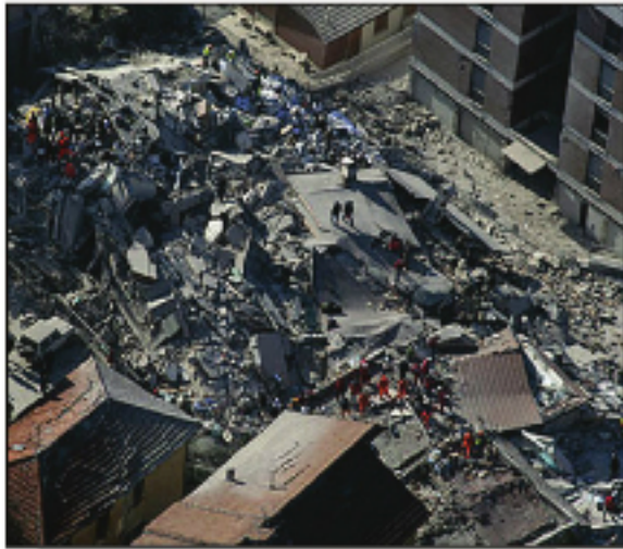
الصورة (٢) آثار زلزال مدمر
