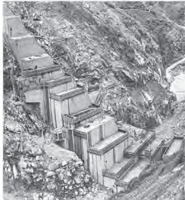
Construcción del proyecto hidroeléctrico Paute, inaugurado en 1983
