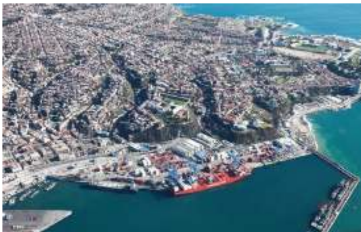
Terminal Pacífico Sur en Valparaíso (Chile)
