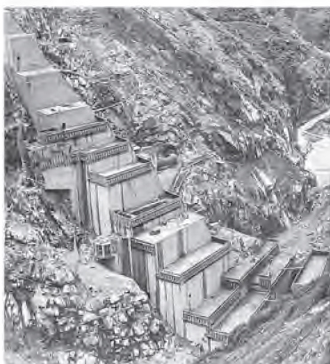
Construcción del proyecto hidroeléctrico Paulo, inaugurado en 1983
