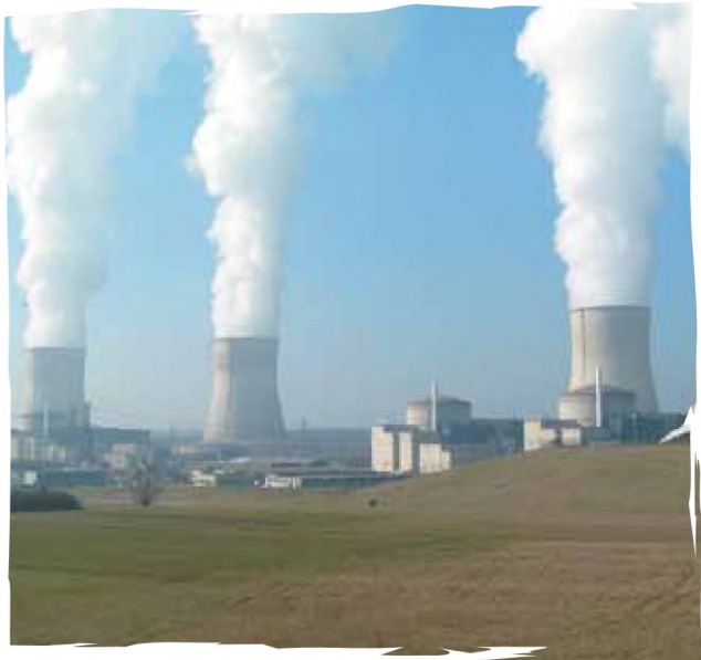
Las chimeneas de las fábricas son altamente contaminantes, para los trabajadores y los habitantes de comunidades aledañas.
