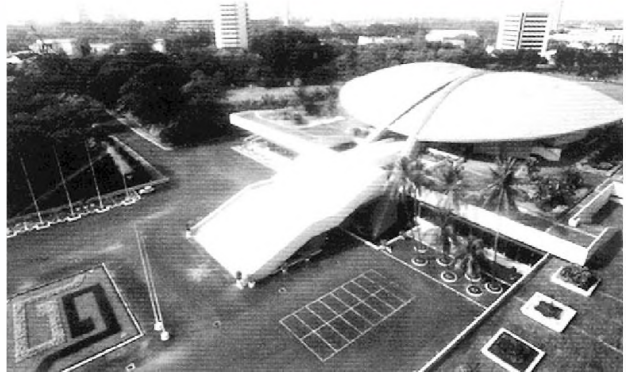
Gambar 2.13 Gedung tempat MPR melaksanakan tugasnya.
