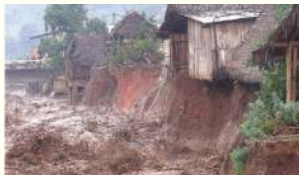
Viviendas en riesgo en la Costa ecuatoriana
