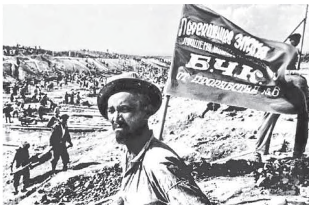
Строительство Большого Чуйского канала.
