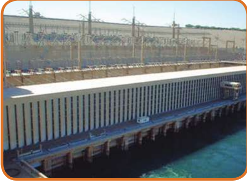
محطة السد العالي لتوليد الكهرباء
