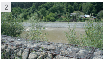
2 Amenajări împotriva inundațiilor pe râul Trotuș
