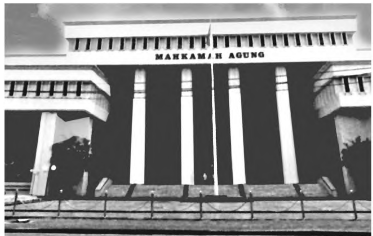
Gambar 1.9 Gedung Mahkamah Agung
