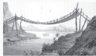
Puente en Penipe
