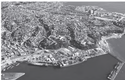
Terminal Pacífico Sur en Valparaíso (Chile)
